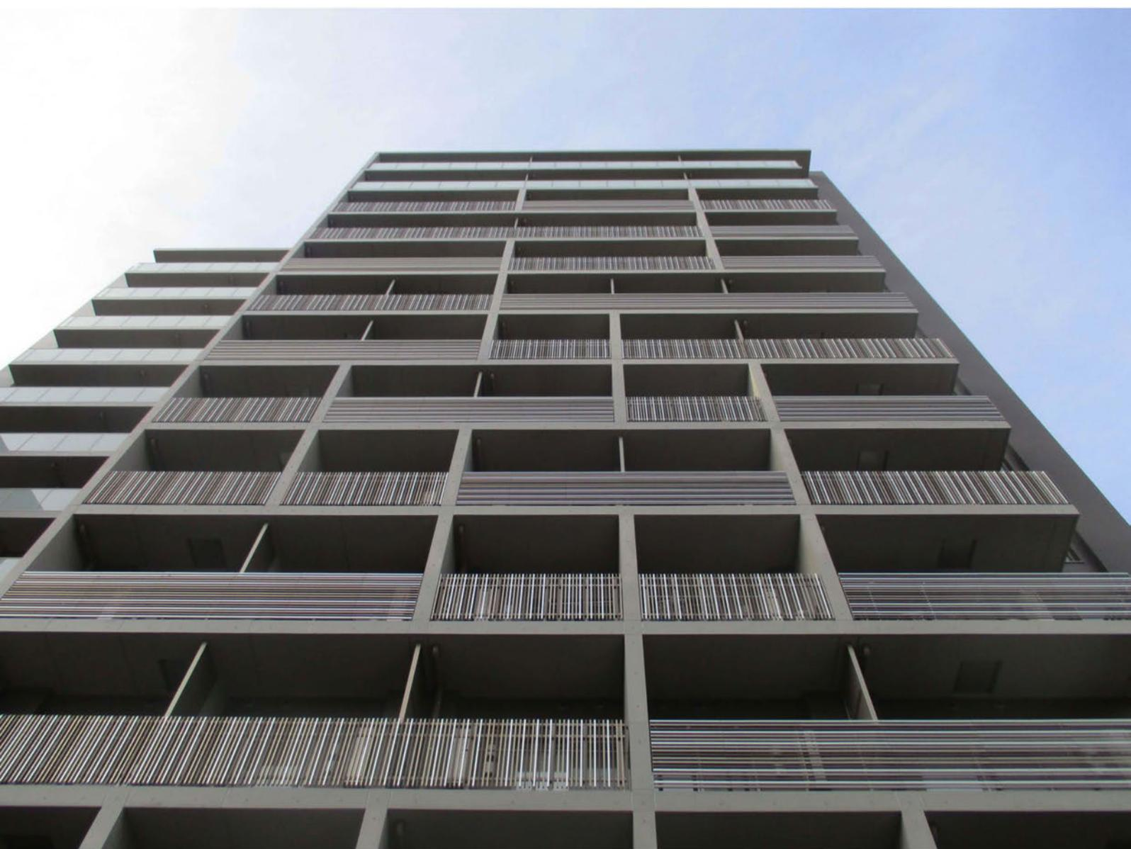
ミネバ<sup>sr</sup>とエイミー<sup>sr</sup>にランダムに焼き付け塗装をした商品です。並び順はバラバラのようですが、配列プログラムにより管理されております。又、縦ルーバー（ミネバ<sup>sr</sup>）を90°回転させると横ルーバー（エイミー<sup>sr</sup>）になりますが、機能も同様に、縦も横も上下左右摺動致します。
